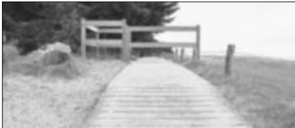
Un platelage avait été installé avant l'été dernier entre l'école de voile du Roaliquen et le domaine des grèves.
